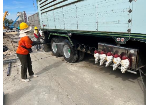
รูปที่ 6 ฉีดล้างล้อรถ
